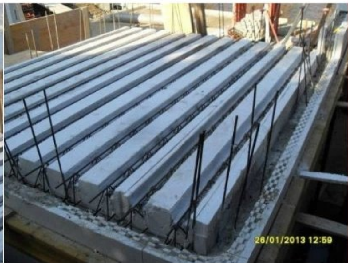
Un solo hombre puede poner las planchas y armarlas
