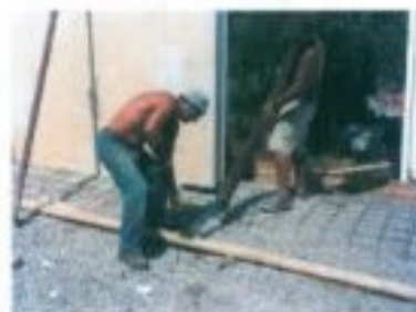
3) Montaggio degli elementi tetto
