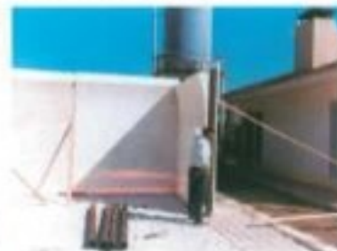
2) Montaggio degli elementi pareti
